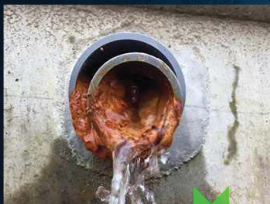
試験開始前の集水管孔口
