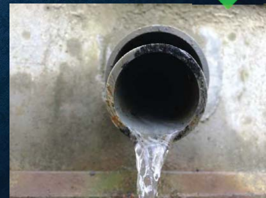
試験終了時の集水管孔口
