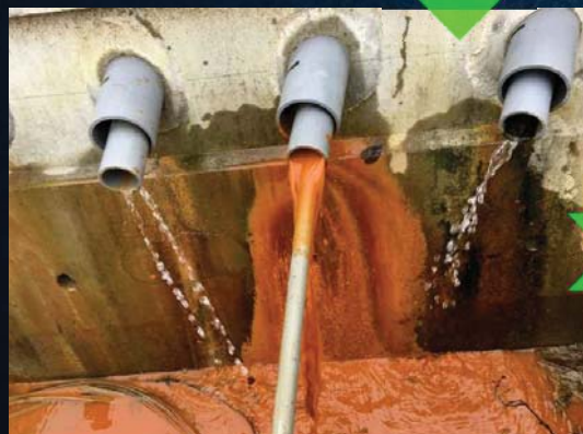
集水管の洗浄
