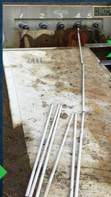
マグネシウム管の設置
