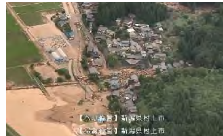
被害状況(新潟県村上市): 地整所有防災ヘリにて撮影
