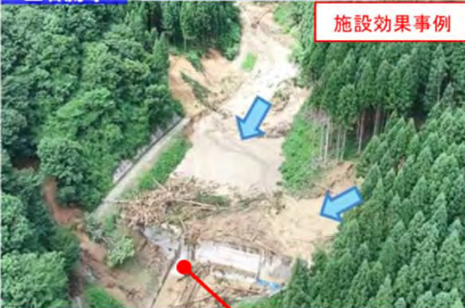
砂防堰堤が土石流を捕捉
