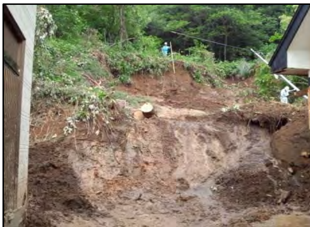
被災状況調査(砂防班)
