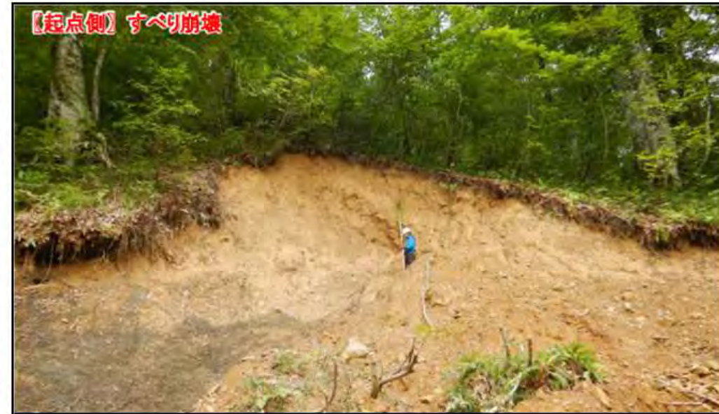
写真-2. 地すべり性破壊(起点側)
