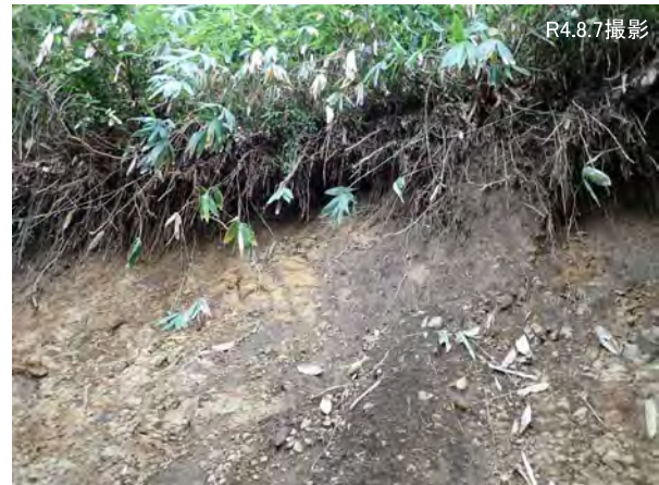
崩壊斜面に分布する椎谷層の状況
