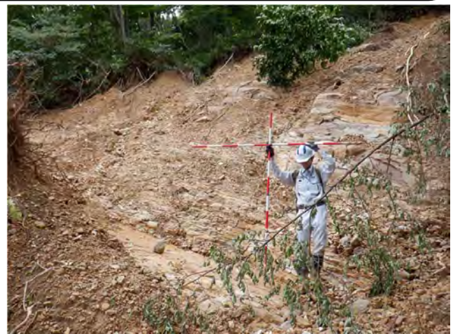
崩壊斜面に分布する七谷層の泥岩・シルト岩
