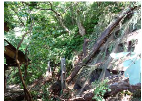
【がけ崩れ】関川村湯蔵地内
