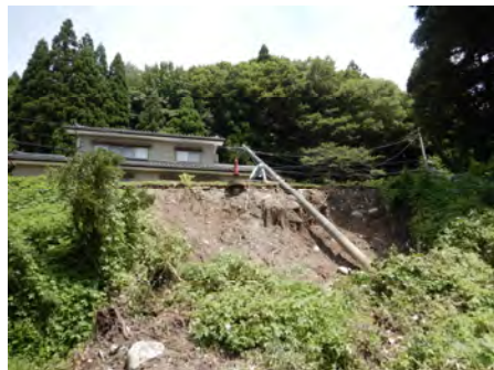
【がけ崩れ】関川村中束地内
