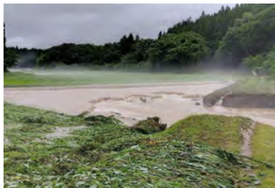
上流で越水した川の水が農地に流れ出し、畦畔や水路・農道が崩壊（村上市布部）
