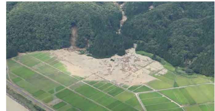
崩壊土砂が農地へ流出（関川村桂）
