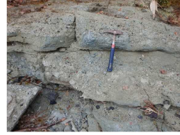
⑦地すべりブロック末端部 緑灰色の火山砕屑岩が観察される。
