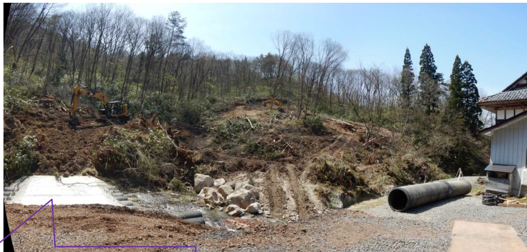
資機材を渡河させるための仮設盛土
