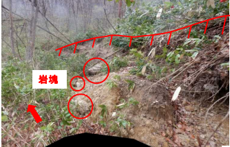
③地すべりブロック頭部より右側方崖の状況 崩壊に伴う倒木が観察される。 崩積土内には最大径1.5m程度の岩塊を含む。
