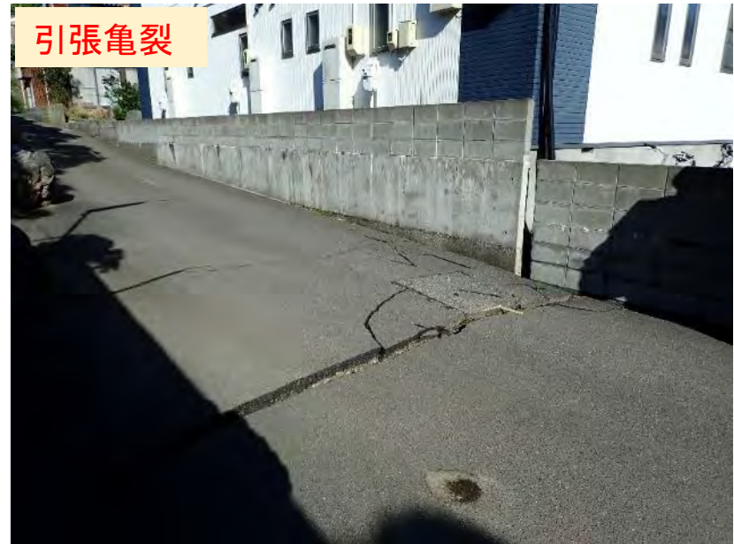
移動斜面：上端：引張亀裂 下端：圧縮亀裂
