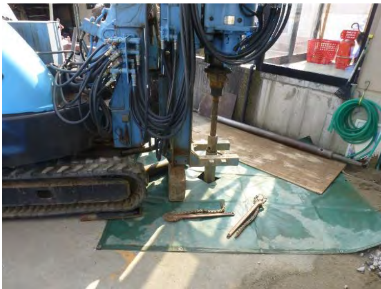
ボーリング調査（自走式機器）
