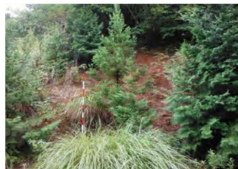
排土工の背後斜面の崩壊
