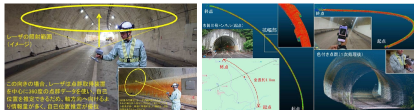
道路トンネルで検証した例
