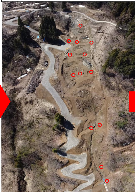
施工中 (R6年4月10日撮影)
