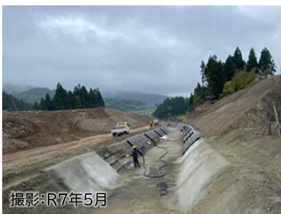
仮排水路工の施工状況
