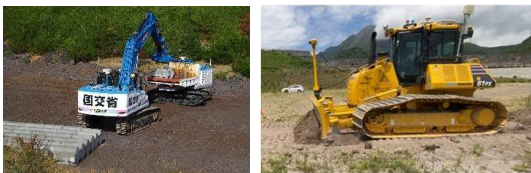
根固めブロック設置状況（把持装置）
