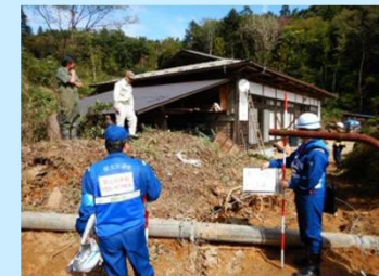
宮城県丸森町における被災状況調査
