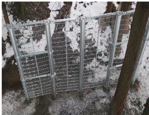
雪崩防護柵の整備
