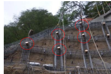
補正台座組立完了
