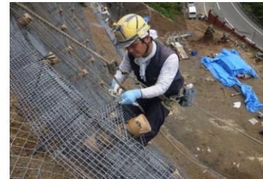
法枠台座加工
