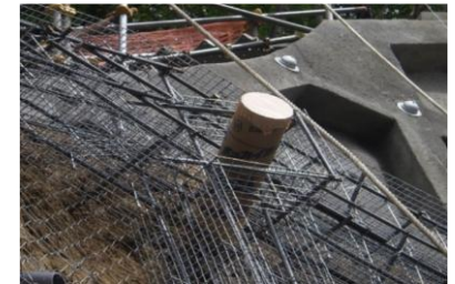
法枠補正台座組立完了
