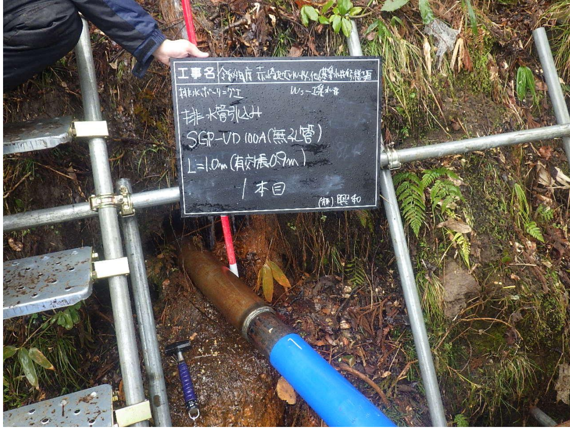
排水管引込状況
