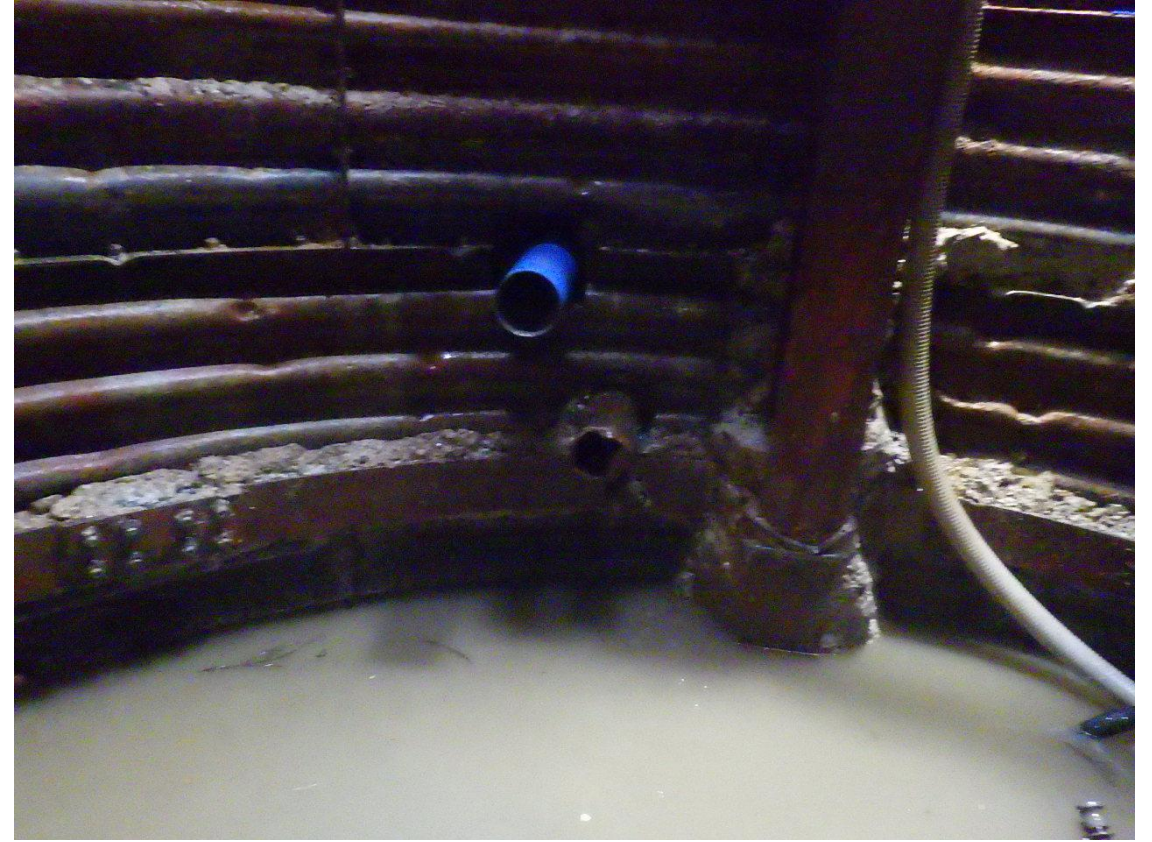
排水管引込完了
